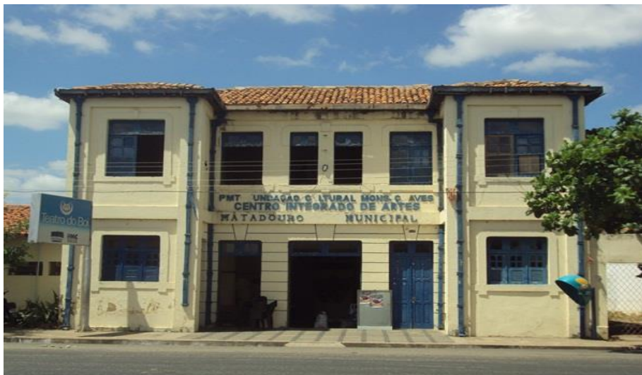
Fotografia 3: Fachada do Teatro do Boi em 2009 (antes da revitalização do PLN) Fonte: Internet 49
